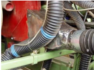
Anpassen eines Schlauches zur Abluftführung (100/150 mm Ø)
